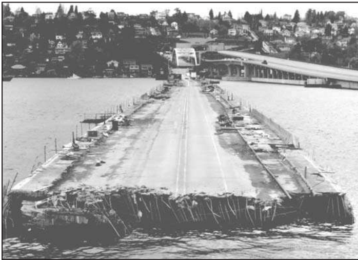
Рис. 8-1. Часть плавучего моста Interstate-90 в Сиэтле затонула во время шторма, потому что резервуары были оставлены открытыми. Они наполнились водой, и мост стал слишком тяжел, чтобы держаться на плаву. Обеспечение защиты от мелочей во время проектирования может значить больше, чем кажется
